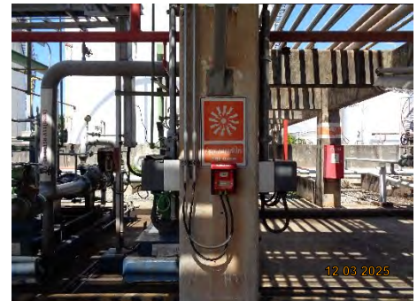
สัญญาณแจ้งเหตุเพลิงไหม้ (Fire Alarm)
